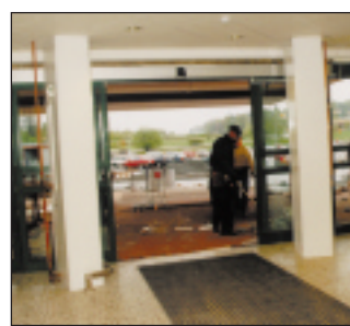
Четыре завесы, установленные в колонны по обеим сторонам большого дверного проема.
